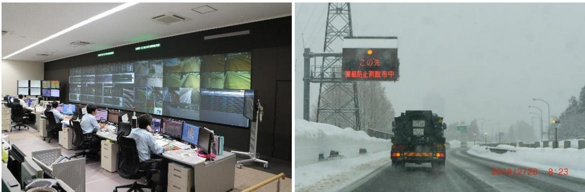
*Illustration 1 (à gauche) : Centre de contrôle de la circulation ; Illustration 2 (à droite) : Panneaux à messages variables (le panneau représenté indique "Voiture à basse vitesse en marche avant")*
