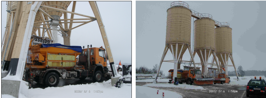
Figure 7 : Chargement par silos de matériaux d'épandage de 250 t
