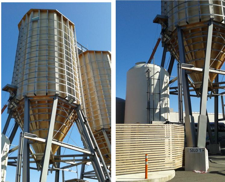
*Silo en bois pour éviter la corrosion et cerclage métallique galvanisé pour assurer la tenue mécanique et une unité de fabrication de saumure particulièrement moderne.*
