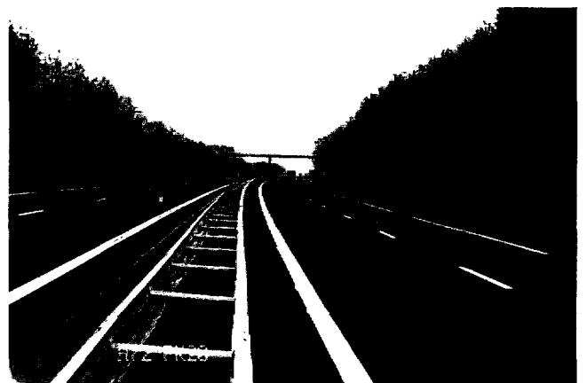
PK 20. — Déblai et ouvrage
