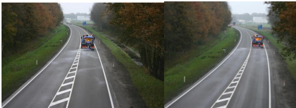
*Illustration 11 : Meilleure répartition du sel avec épandage pré-humidifié (côté droit) par rapport à l'épandage à sec (côté gauche), exemple de l'Allemagne*
