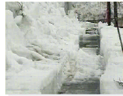
Trottoirs non nivelés
