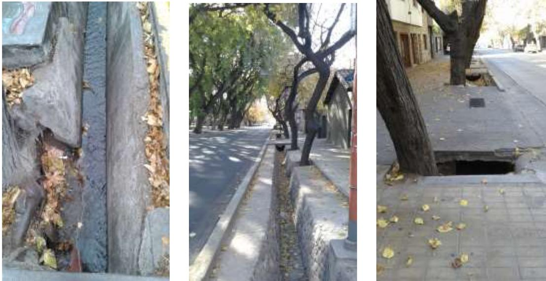
*Des précipitations rares mais parfois intenses canalisées par un réseau pluvial implanté dans les trottoirs, collecte des eaux et irrigation des arbres.....Prudence lorsque l'on circule après que la nuit soit tombée.*
