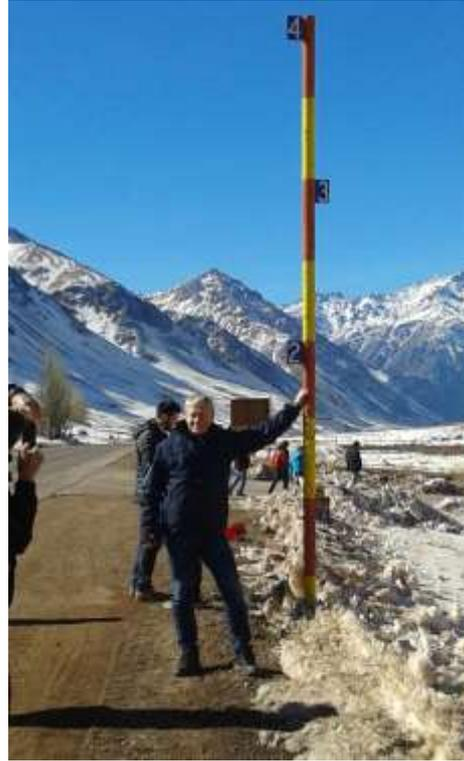
*Chaussée béton en altitude (3200 m) et jalon (de 4 m) adapté à la hauteur des chutes de neige....*
